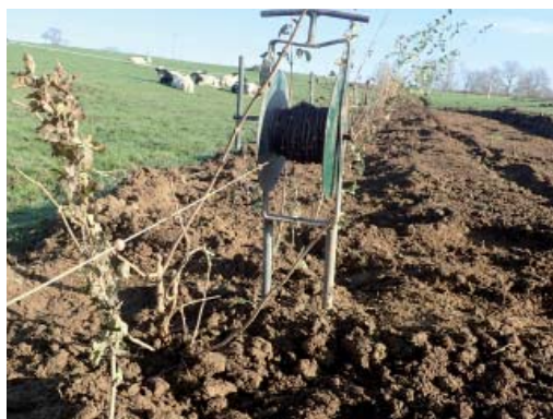
Photo de gauche : utilisation d'un sac de plantation.
